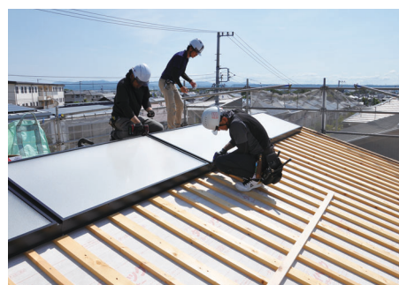
ユニット化された〈びおソーラー〉の集熱パネル。屋根への組み込み方式ではない、「置き式」ですので、工事もうラクで、スッキリ美しく納まります。
