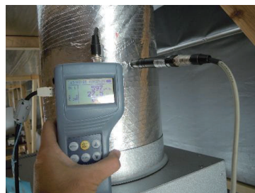
風量測定の様子
