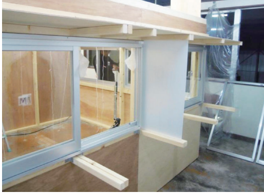
実験棟 (開口部)
