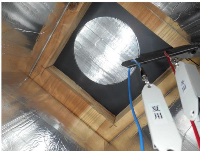
集熱パネルのダクト接続口が塞がっていて、集熱空気が入って来ない状態。
